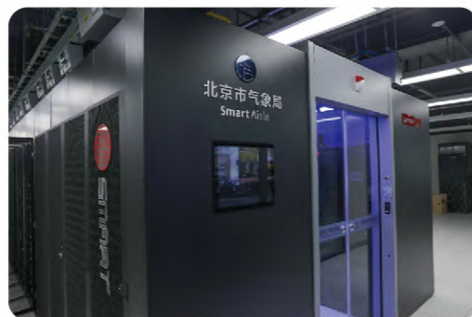
联想为北京气象局部署的温水冷却高性能计算系统
