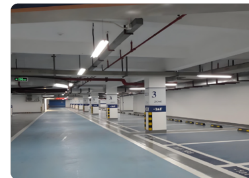
▲ 社会停车场照明改造示范项目
